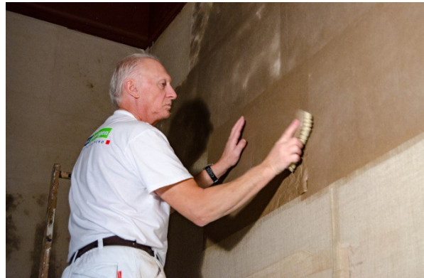
Grondvellen aanbrengen
