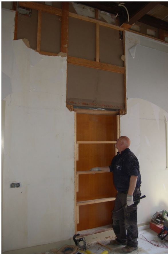
Verborgene triplex inbouwkast
