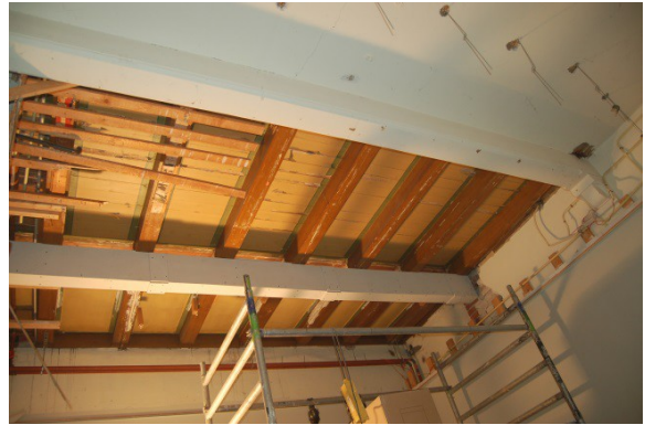
Plafond met opvullatten
