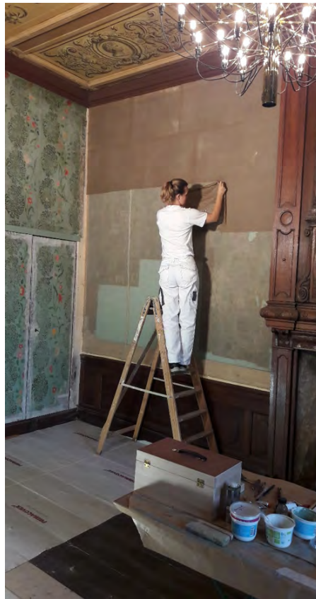
Afb. 5a - plakken van het grondpapier in blokverband
