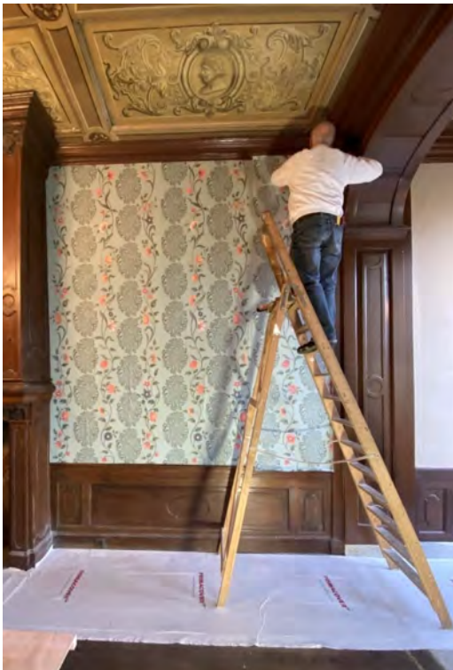
Afb. 12b t/m 12, het plakken van het reconstructie behang
