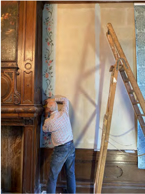
Afb. 12b t/m 12, het plakken van het reconstructie behang
