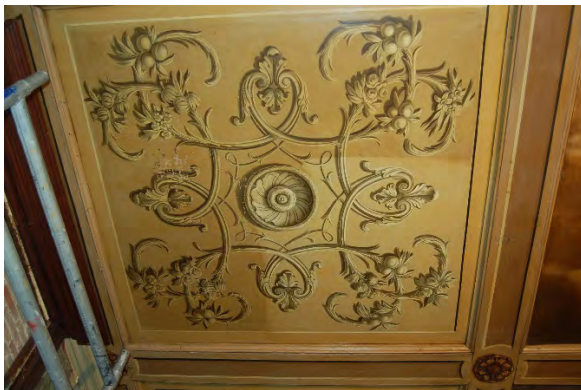
Afb. 3b - deels gereinigde plafonpanelen
