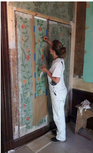
Afb. 6 en 6a - proefdeel op linnen van opgaande tak met bloemen Afb. 6b - proefdruk ornament
