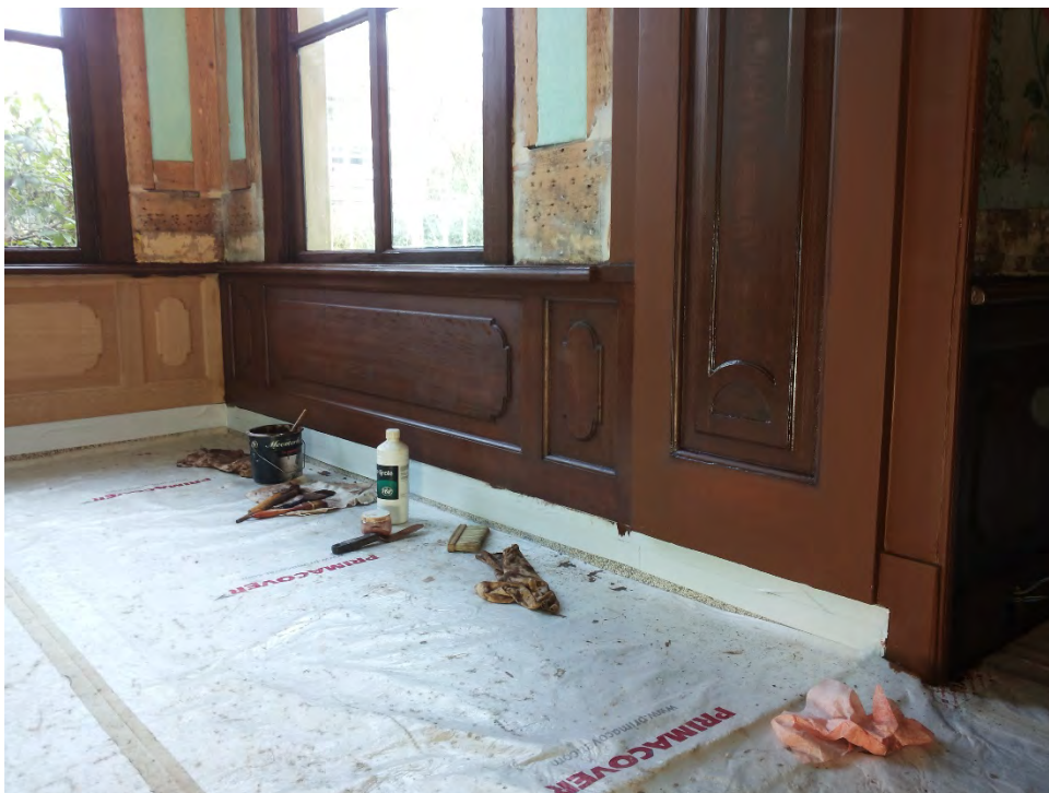
Afb. 4b - kleurwerk lambrisering met gebrande omber in rauwe lijnolie
