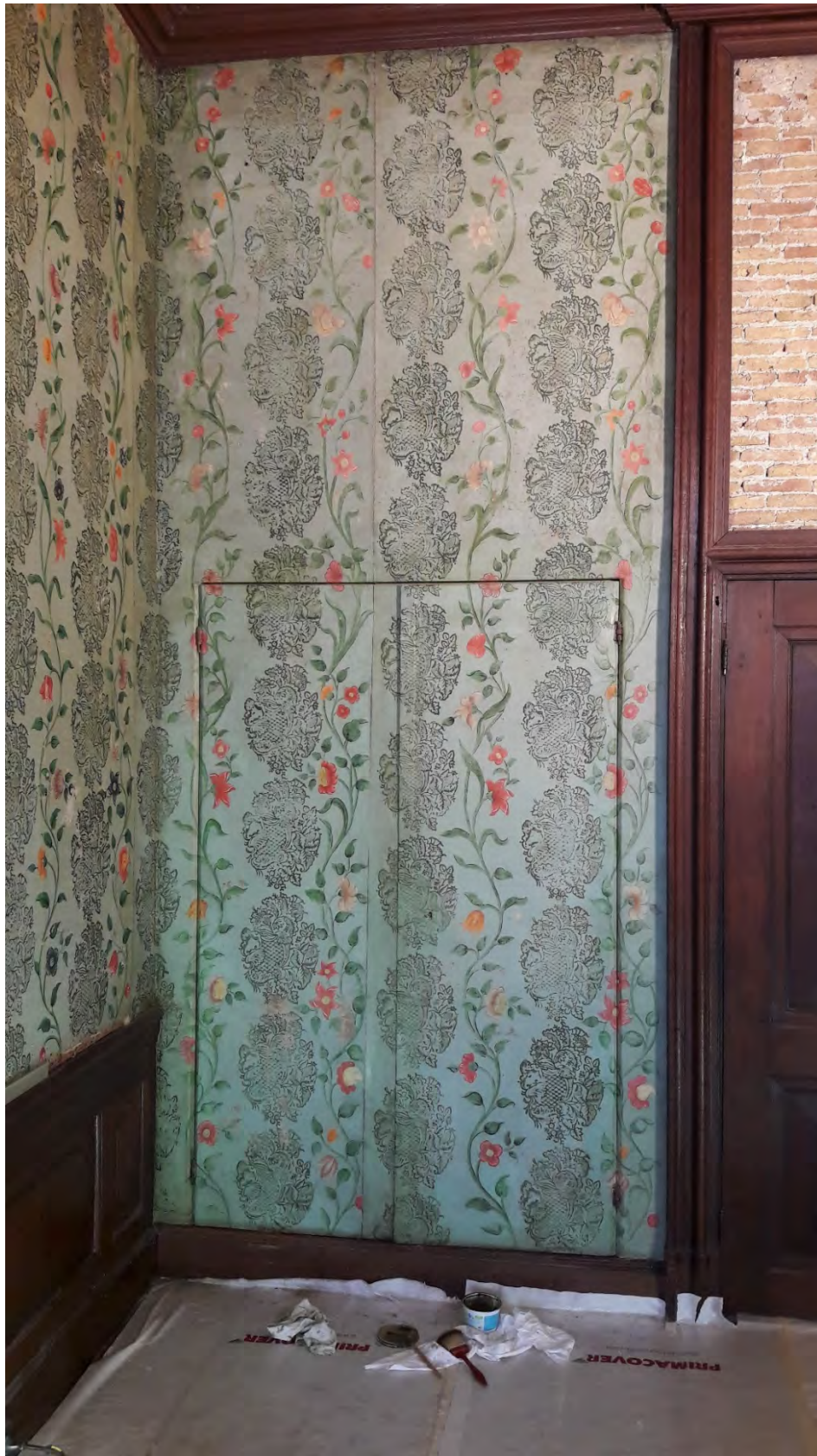
Afb. 7f - herstelde situatie kastenwand linkerzijde van de entree deur
