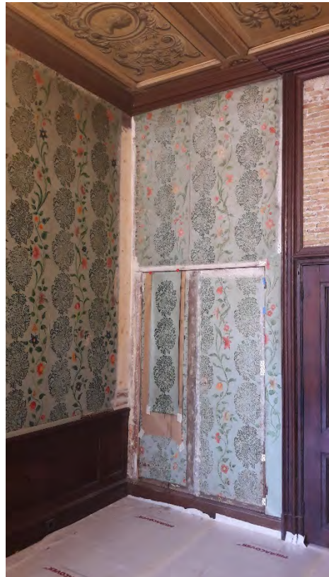
Afb. 8a - herstel van de kant plank
