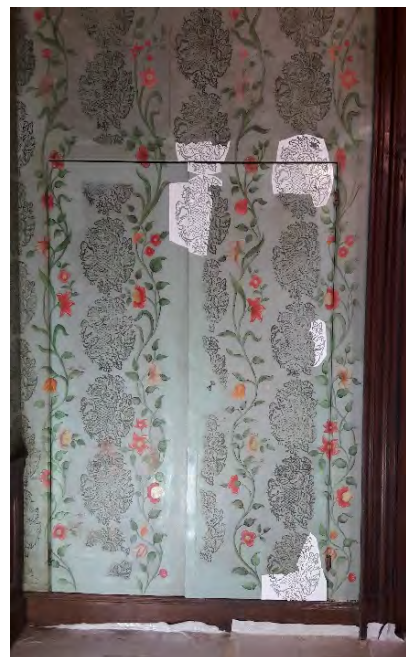
Afb. 7c – aanvulling met sjabloonfolie
