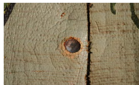
Afb. 2b en 2c - originele bolkop nagels
