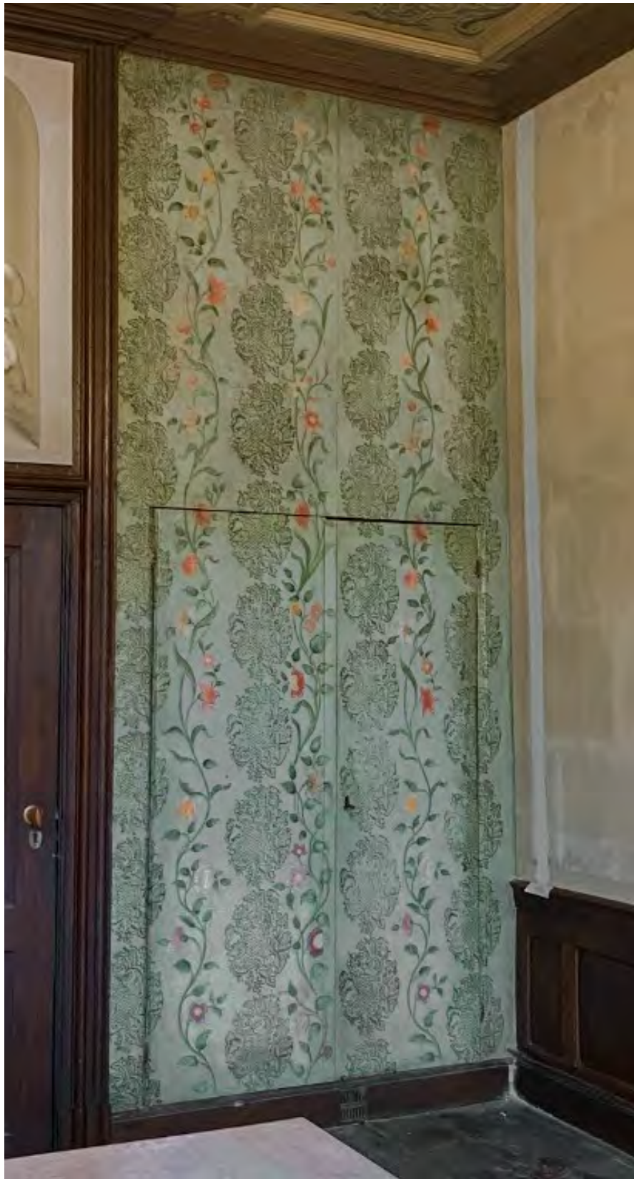
Afb. 7g - herstelde situatie kastenwand rechterzijde van de entree deur
