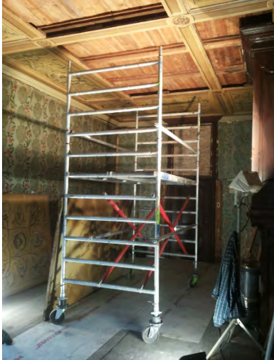
Afb. 3 - verwijderde plafondpanelen
