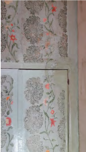
Afb. 7 - linnenstroken gekleurd, rechts deels geglaceerd
