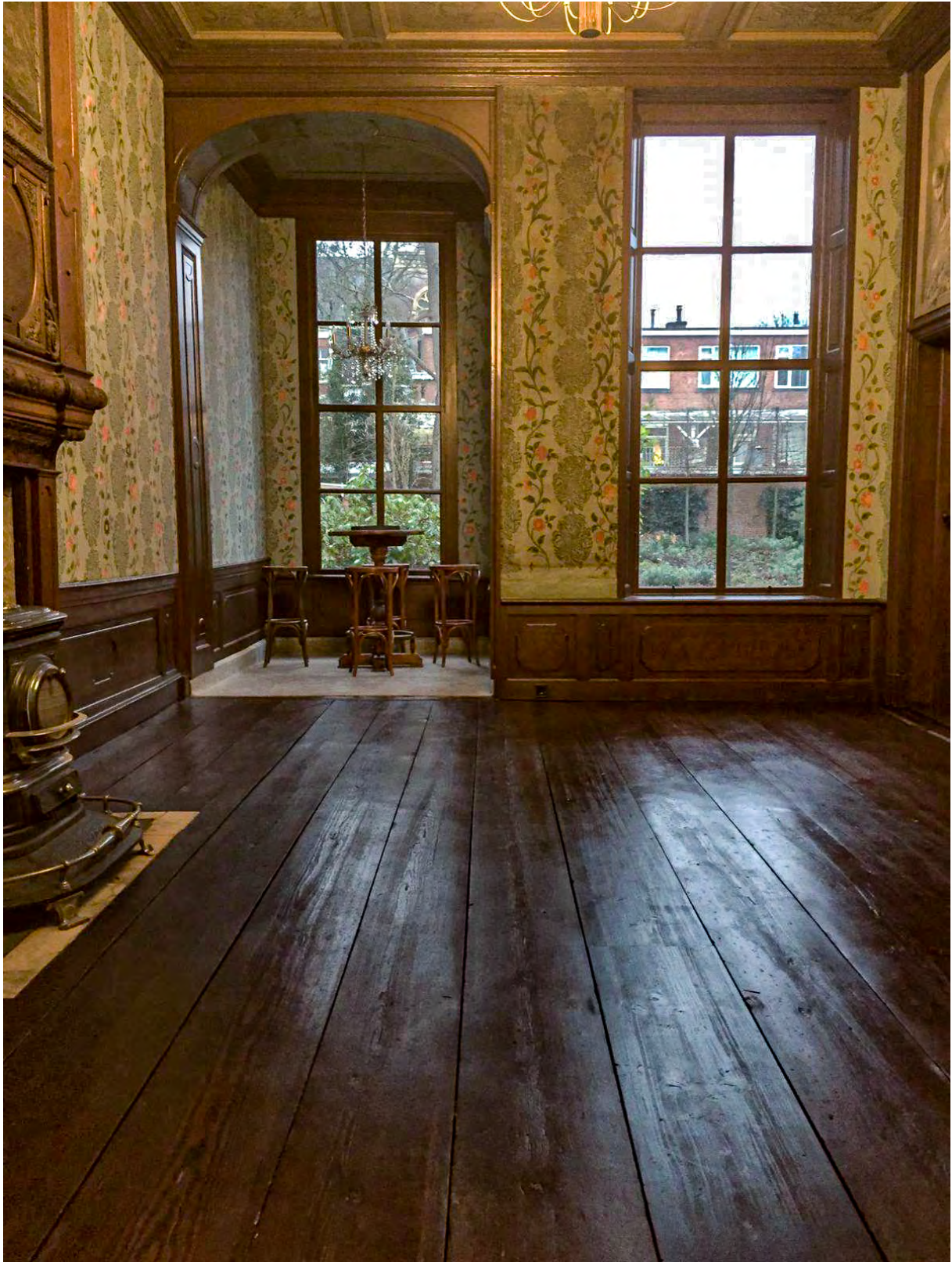
Situatie december 2019, de vloerdelen zijn gekleurd en in de was gezet.
