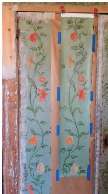
Afb. 6 en 6a - proefdeel op linnen van opgaande tak met bloemen Afb. 6b - proefdruk ornament
