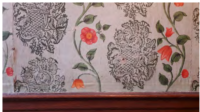
Afb. 8g - onderste 5 cm zijn aangeheeld in de breedte van het oorspronkelijke linnenbehang
