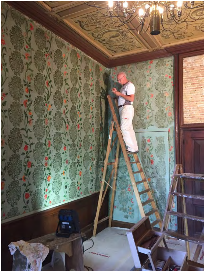
Afb. 8b - herstellen en glaceren van de rococo ornamenten in de zuidoosthoek.
